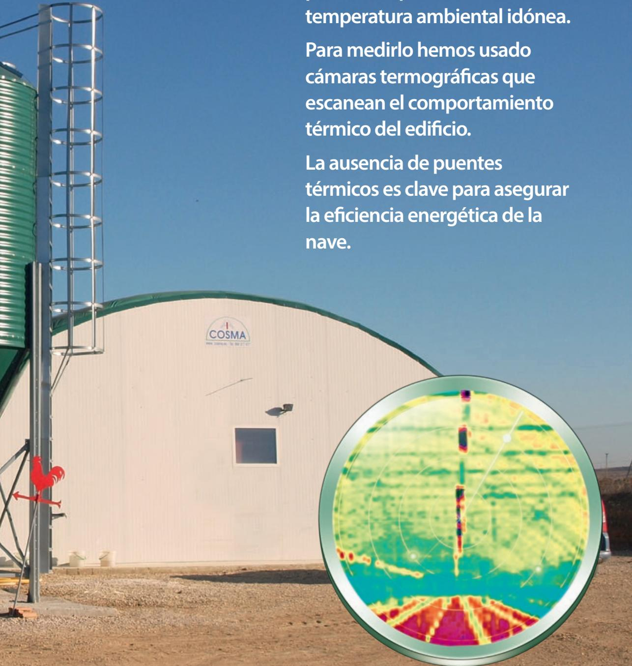
Son cuatro los tipos de materiales que se emplean habitualmente en la construcción de naves avícolas: poliuretano **proyectado**, poliuretano **inyectado** entre dos capas de distintos materiales (formando paneles), poliestireno **extrusionado** y fibra de vidrio.
